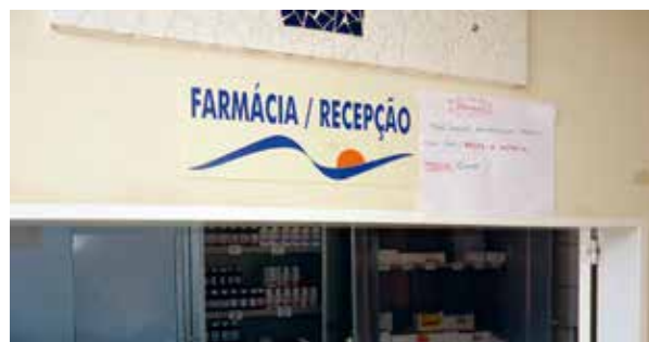
Farmácia funcionando junto com a recepção, mostrando inadequação do setor farmacêutico no local, pois não há um ambiente específico para armazenar os medicamentos
