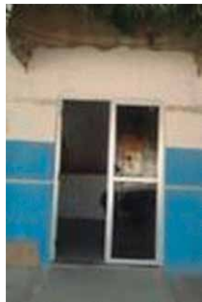
Figura 2. Fachada da CAF anterior à implementação da gestão
