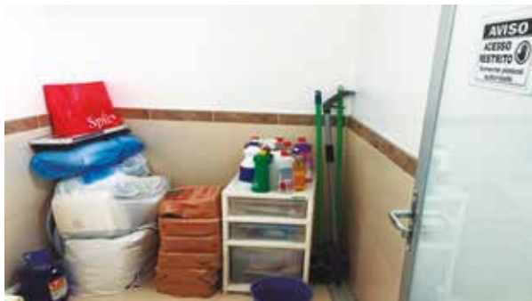
Depósito de Materiais de Limpeza (DML) - Faltam armários para a guarda de materiais e utensílios e não tem tanque para lavagem
